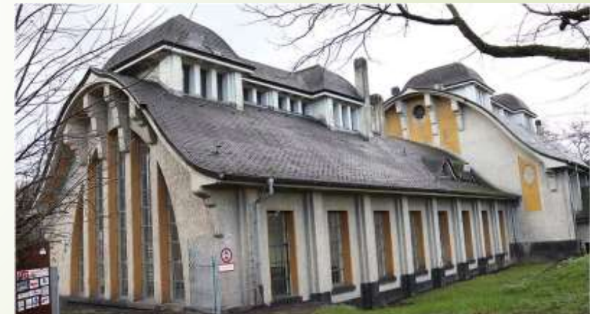
Historická ČOV „Klärwerk“ Uerdingen Foto: Tania Beilfuß
