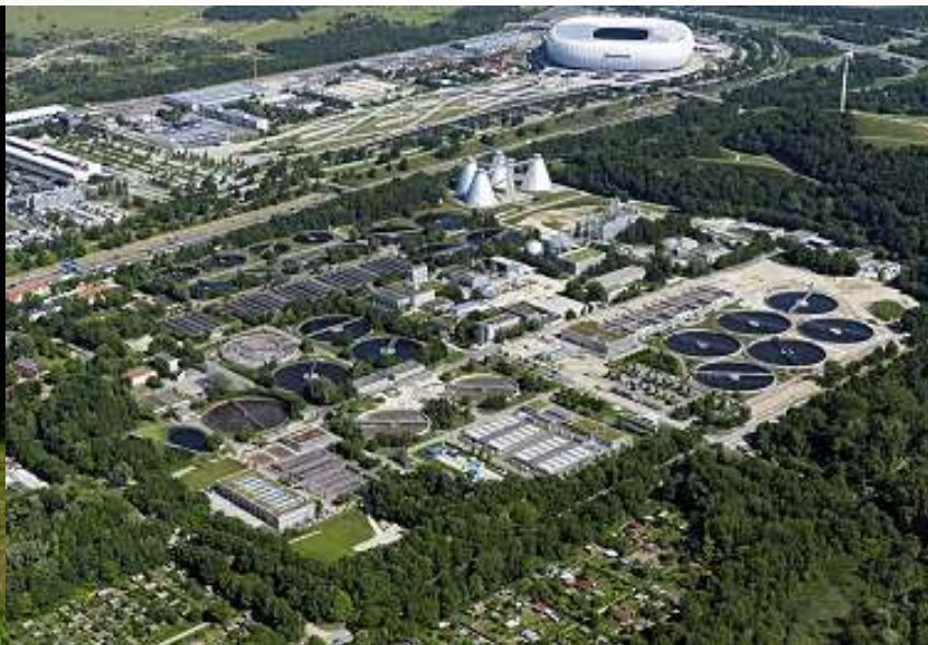
ČOV Gut Großlappen nyní (Teď ČOV Mnichov I)
