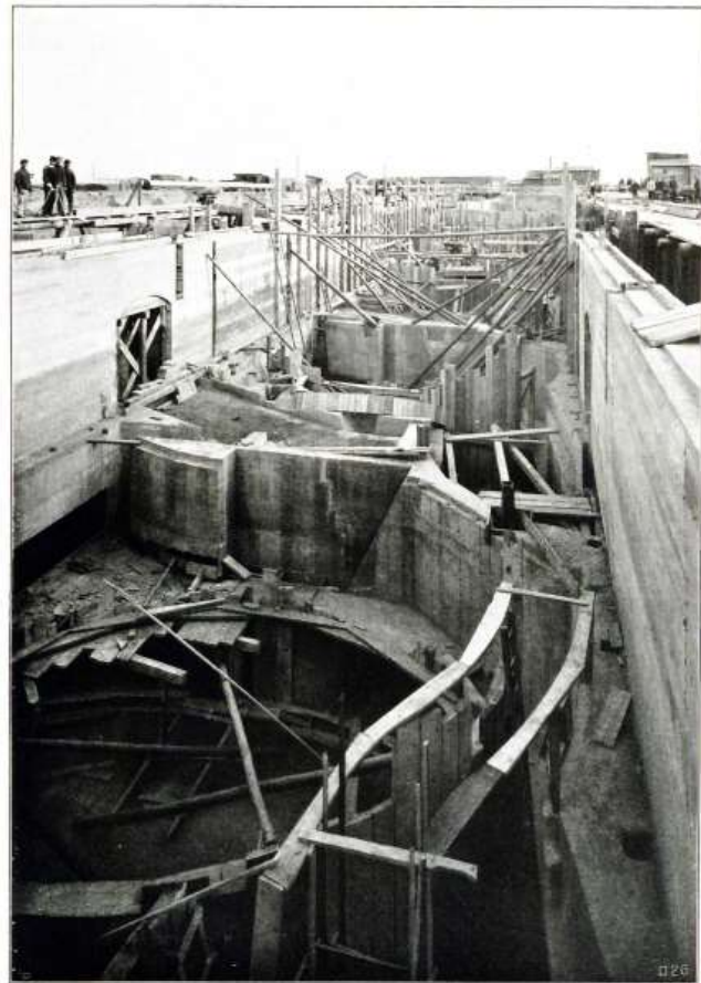
Kanalisation der Stadt Dresden. Reinigungsanlage in Flur Kaditz mit Separatorscheiben, Patent Riensch. Länge des Bauwerkes ca. 60,0 m, Breite mit den seitlichen Kanälen ca. 24,0 m, Tiefe 8,0 m. 1908.
