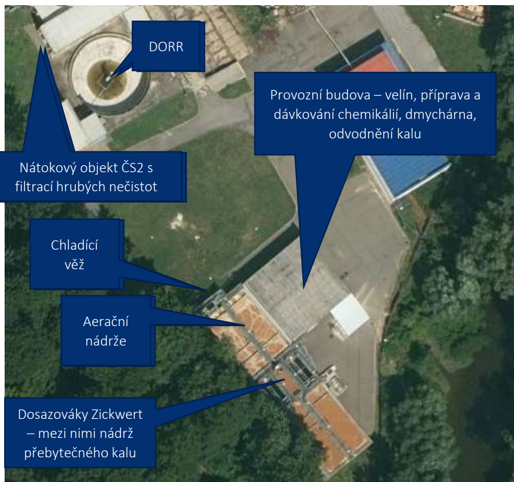
Současná biologická čistírna odpadních vod
