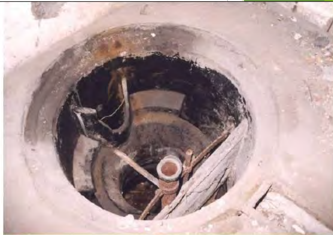
R 6 MO – S 6 typ kruhový, podtyp ostravský, se skluzy na víku ZNAK: 4 nálitky, 2 potrubí (sací a míchací), 1 rovná stěna
