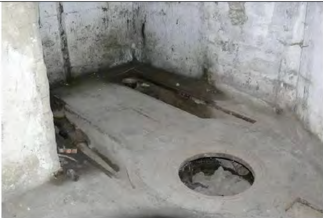
R 5 MO – S 5 (foto Daniel Povolný) typ kruhový, podtyp ostravský, se skluzy za čističem ZNAK: 2 potrubí (sací a míchací), 2 půlkruhové stěny
